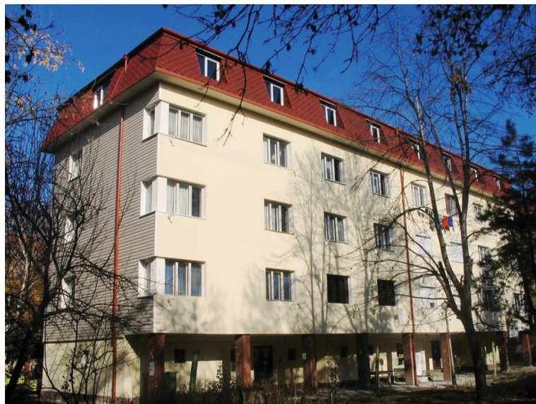
Фигура 3. Изгледи от реконструираната пилотна сграда в ж.к. „Захарна фабрика“ – фасади юг – запад. Фото Г. Георгиев
