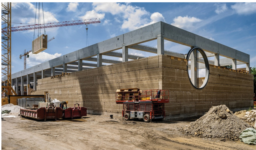
Фигура 3. б. Рикола център, строителното изпълнение от предварително изработени сглобяеми елементи. (Herzog & de Meuron, 2015)
