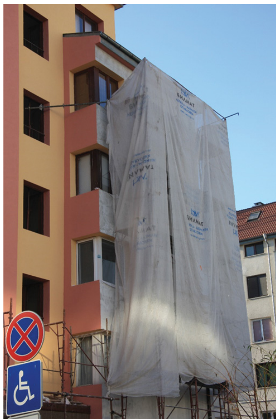
Фигура 5. Апартаментна сграда на ул. „Кирил Божилов“ 18, гр. София по време на строителните работи. Готовата обновена сграда е показана на интернет страницата на проект REECL. Фото Г. Георгиев
