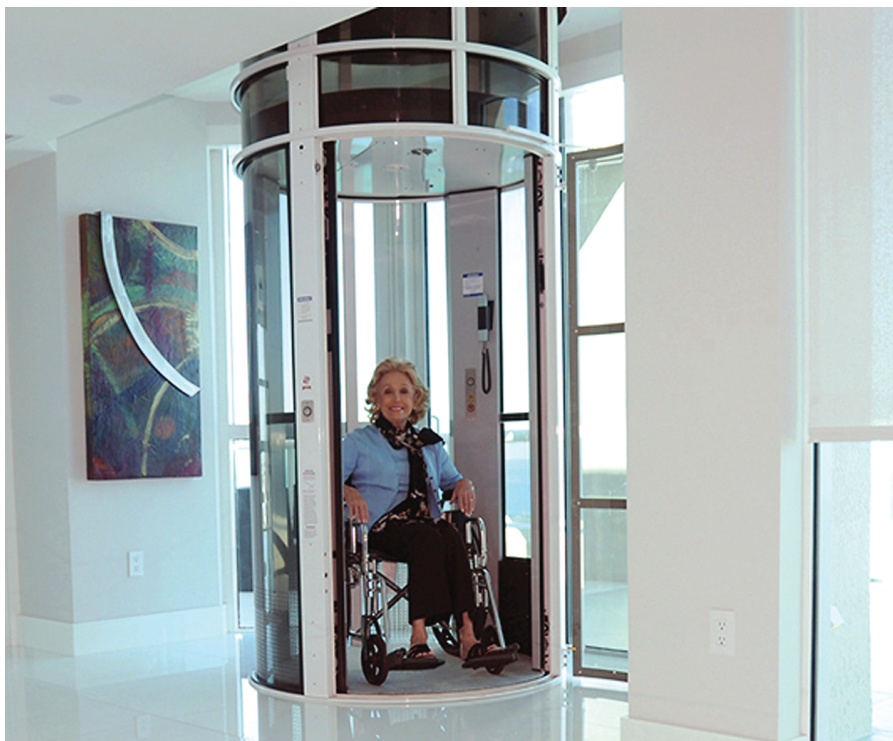
ил. 78. Осигуряване на вертикална комуникация за хора с увреждания чрез пневматичен вакуумен асансьор за жилищни интериори. Ascent mobility. Денвър.
