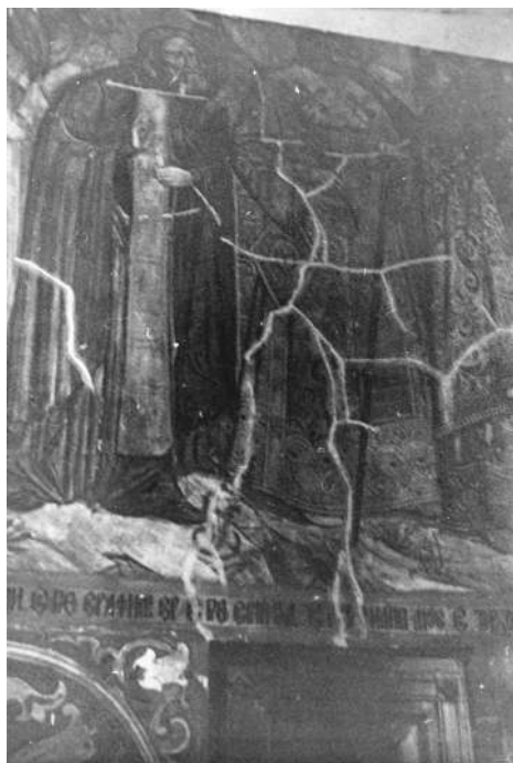
Ил. 3. Мрежовидни пукнатини по мазилката. Фотография: М. Малецки. ЦДА, ф. 1892К, оп. 1, а. е. 126, л. 5, обр. 103
